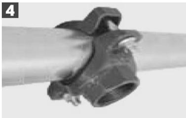
Установите вторую часть корпуса на трубу, наживите болты.
