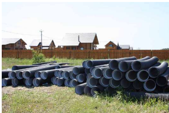
Объект: Коттеджный поселок Перелески, МО, г.о. Истра Подрядчик: ООО «ТД Магнат»
