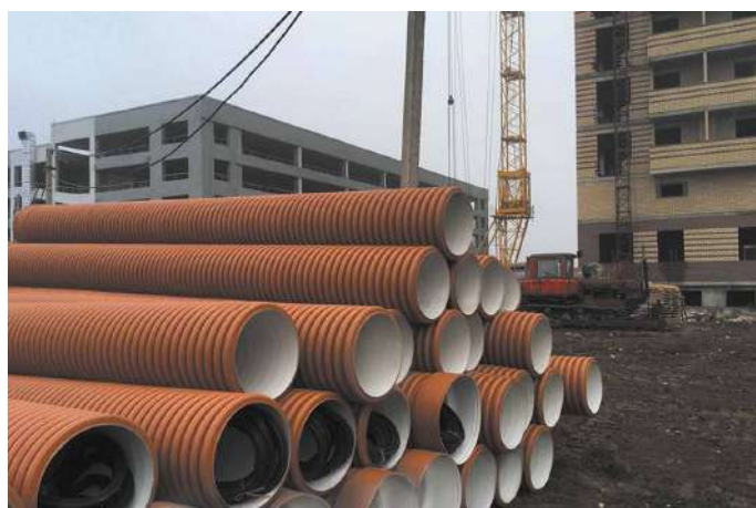
Объект: Жилой комплекс «Екатерининский», г. Ростов-на-Дону Подрядчик: ООО «Горстройснаб»
