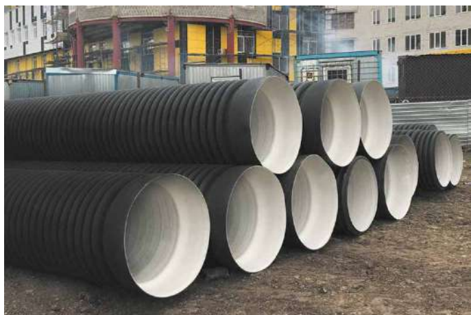
Объект: Реконструкция канализации, г. Белгород, ул. Есенина Подрядчик: ООО «Фланец-Комплект»
