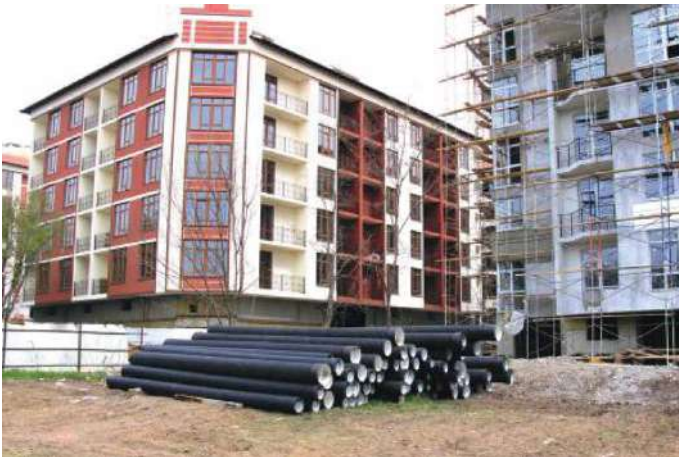
Объект: Прокладка коммуникаций, г. Геленджик Подрядчик: ООО «СМ-Строй»
